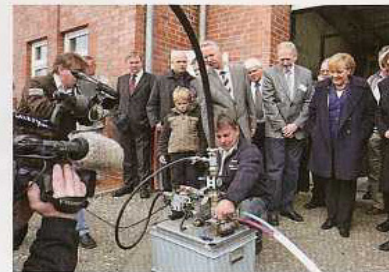
Vorführung Glasfasereinblasen mit der Firma Vetter. Burkhard Köpke bläst dem „Minijet“ die Faser in Rohre mit Durchmesser von 4 bis 16 Zentimeter
