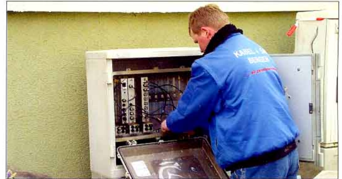
Kundenservice wird bei der KSB groß geschrieben: Mitarbeiter Jan Hoder bei der Überprüfung der Strecke des Magistralnetzes.
